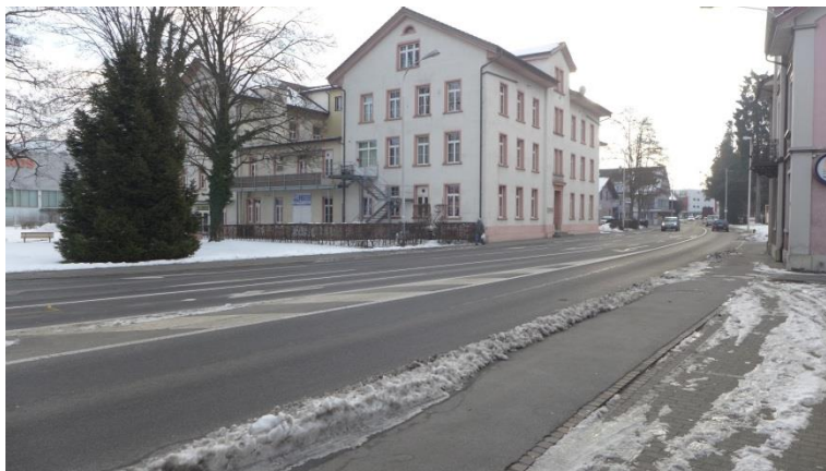
Abbildung 23: Verkehrsorientierte Hauptachse: Hauptstrasse Reinach bei Hochhauskreuzung mit Blickrichtung Zentrum.
